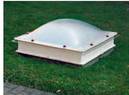
Richtig: Die Lichtkuppel ist gemäss der zulässigen Überstauhöhe eingebaut
