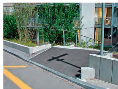
Diese Rampe verhindert den Zufluss von Strassenwasser über den Treppenzugang.
