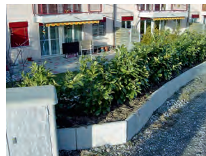
Dieser Stellriemen schützt das Grundstück vor Strassenwasser.
