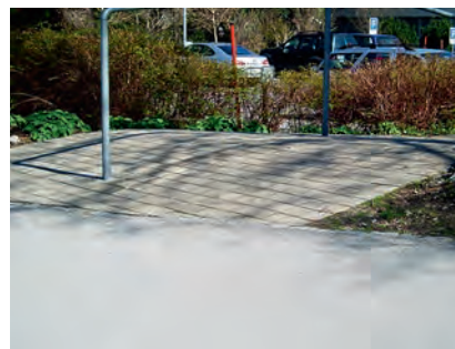
Rampe zur Überwindung eines umgrenzenden Erddamms.
