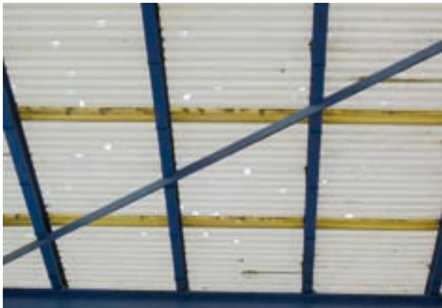
Abbildung 6.17: Kunststoffplatte Dach, Foto GVZ .
