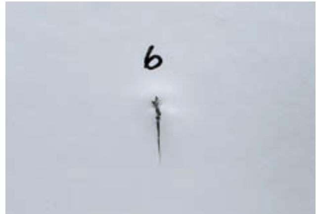
Abbildung 6.14: Dichtungsbahn PVC-P, Foto Empa.
