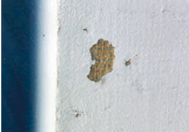
Abbildung 6.11: armierter Putz auf Aussenwärmedämmung, Foto GVL.
