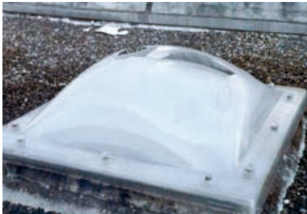
Abbildung 6.15: doppelschalige Lichtkuppel, Foto ECAB.
