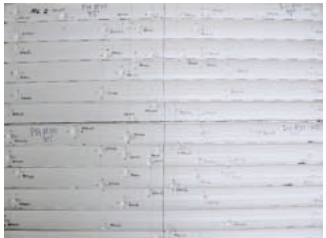
Abbildung 6.4: Rollladen, Foto Empa.
