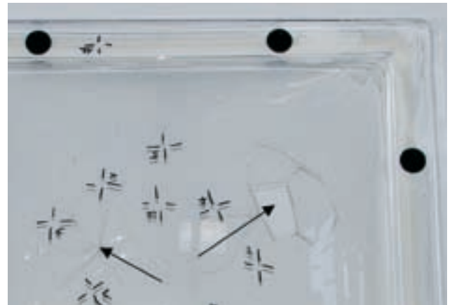
Abbildung 6.16: doppelschalige Lichtkuppel PMMA, Foto Empa.
