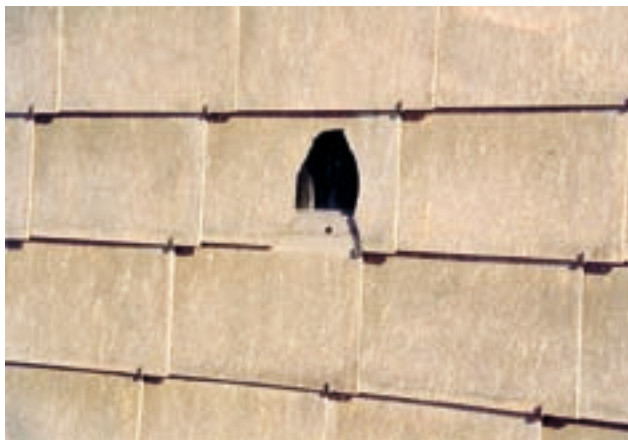
Abbildung 6.9: Faserzementschiefer Fassade, Foto GVZ.
