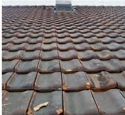
Absplitterung Ziegeloberseite
