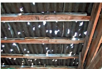
Perforation von Faserzementwellplatten
