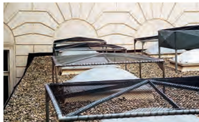
Hagelschutzgitter über Lichtkuppeln.
