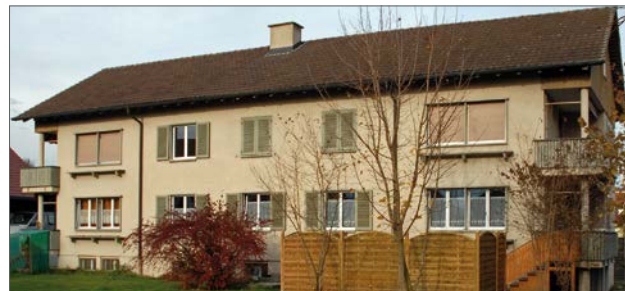
Wohnhaus von 1960 in Kriessern SG: Die Erdbebensicherheit wurde im Rahmen der Planung von Erhaltungsmaßnahmen durch einen spezialisierten Erdbebeningenieur überprüft und als genügend bewertet.
