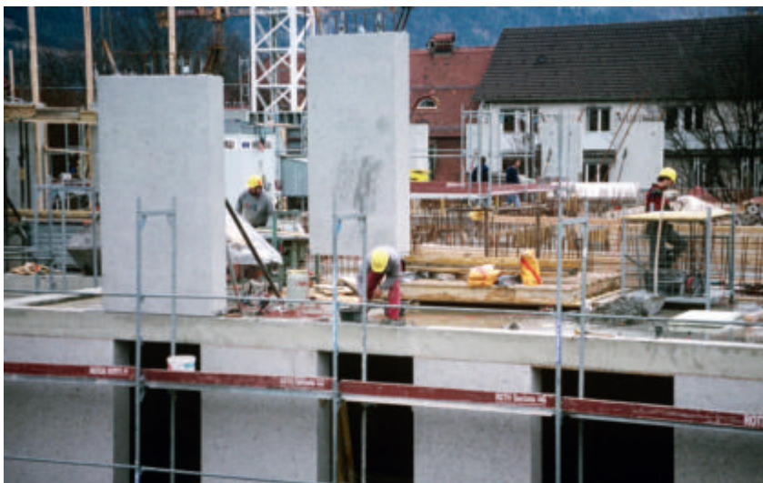
Die massiven Elemente, aus denen ein Tragwerk besteht, kann man während dem Bau eines Gebäudes besonders gut erkennen. Bild: M. Weidmann
