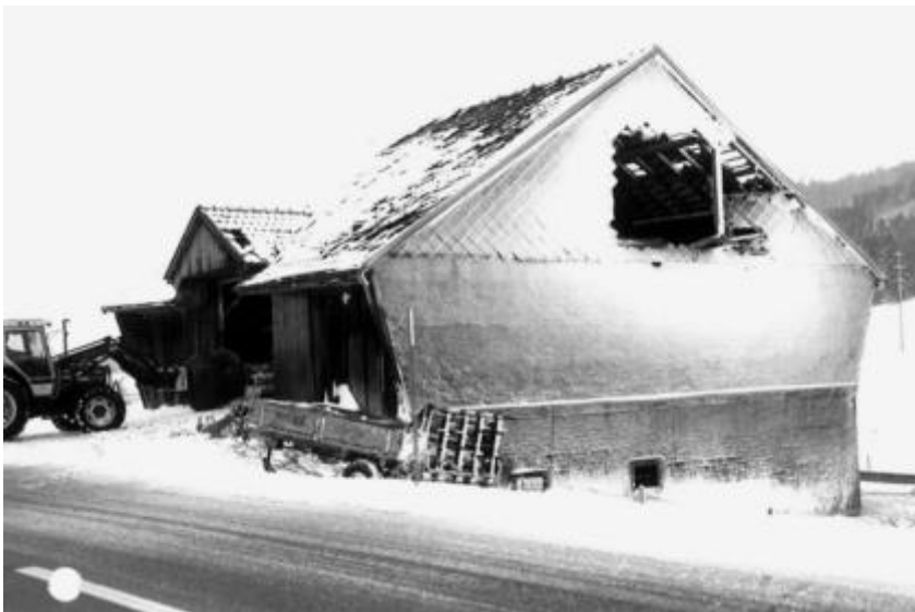
Grössere Schäden am Dach und an der Fassade eines Stalles durch Lothar, 1999. Bild: Gebäudeversicherung Freiburg
