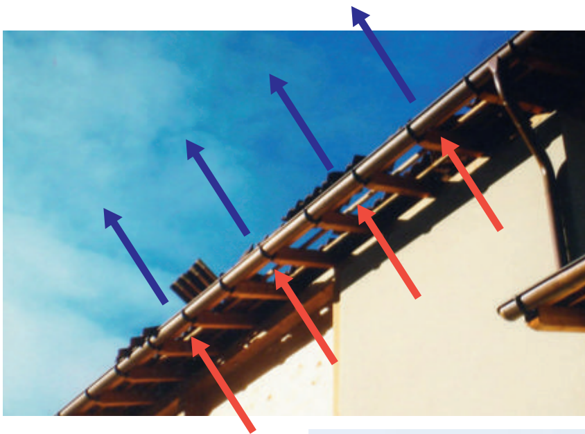
Deckmaterialien (z.B. Ziegel) von Vordächern ohne Dachuntersicht sind der Sogbeanspruchung schon bei geringen Windgeschwindigkeiten nicht mehr gewachsen. Bilder: Gebäudeversicherung Graubünden
