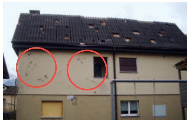
Dächern weggeweht werden, führen zu Schäden an den Fassaden benachbarter Gebäude (rote Kreise).
