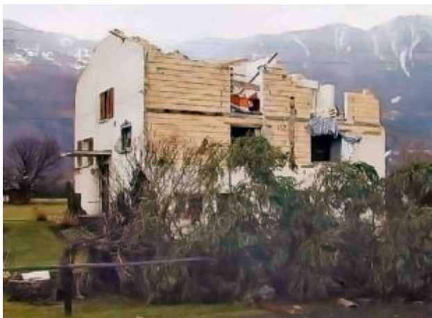
Von Lothar-Sturmböen zerfetzte Dächer. Bild links: Gebäudeversicherungsanstalt des Kantons St. Gallen; Bild rechts: Gebäudeversicherung Bern
