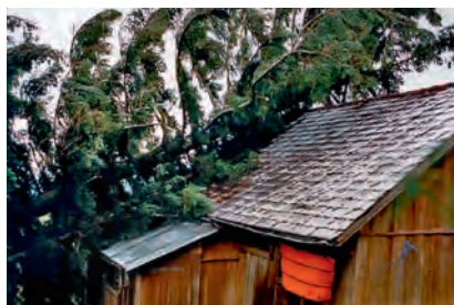
Beispiel eines Schadens durch den Sturz eines Baumes.
