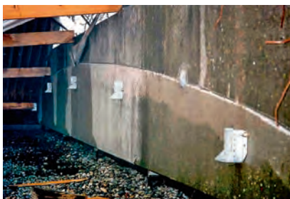
Die offene Deckunterlage führte zu einer Überlagerung von Innendruck und äusserem Windsog. Das Dach hielt dem nicht stand.
