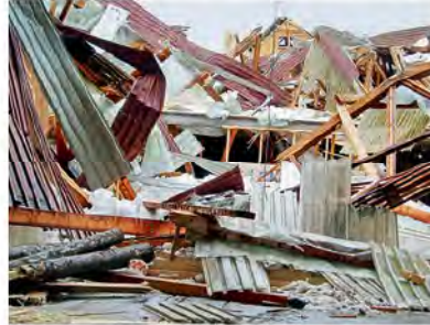
Beispiele von Hallendacheinstürzen mit Holz- und mit Stahlträgern.
