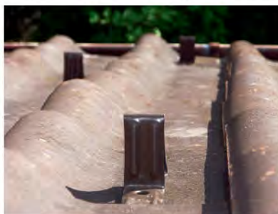
Beispiel einer Schneestoppvorrichtung.
