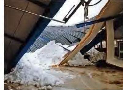
Beispiele von Hallendacheinstürzen mit Holz- und mit Stahlträgern.
