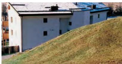
Eine gute Einpassung in das Terrain schützt die Bauten vor dem direkten Lawinenangriff. Dies geschieht durch eine vertiefte Anordnung des Gebäudekörpers. Die lawinenseitig zu schützende Aussenwandfläche verringert sich mit dieser Massnahme.
