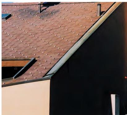
Dachvorsprünge sind lediglich bei Seitenwänden erlaubt, wenn sie genügend geschützt sind.
