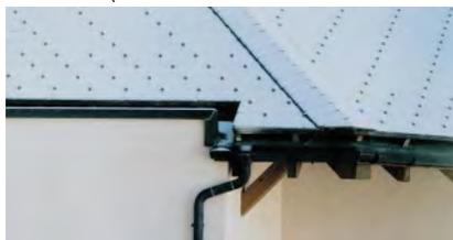
Bergseitige Dachvorsprünge sind zu vermeiden, wenn mit der vertikal von unten gerichteten Lawineneinwirkung gerechnet werden muss (Gefährdungsbild 2). Das Dach ist in die lawinenseitige Aussenmauer zu versenken (vgl. Fotos).
