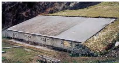
Als Ebenhöch werden Bauten genannt, deren Dach bergseits nahtlos an das Terrain oder eine Anschüttung anschliesst. Die Lawine fliesst dadurch über die Baute hinweg. Besondere Beach-
