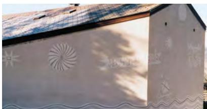
Die Formgestalt der Baute bestimmt die effektiv wirkenden Drücke auf die betroffenen Aussenwände. Keilförmige oder zumindest abgewinkelte Grundrissformen sind in Bezug auf die Hauptzuflussrichtung der Lawine günstig.
